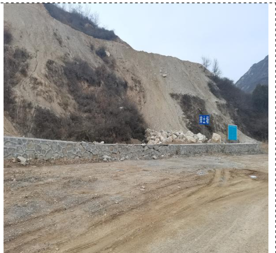
依托排土场及挡土墙建设情况
