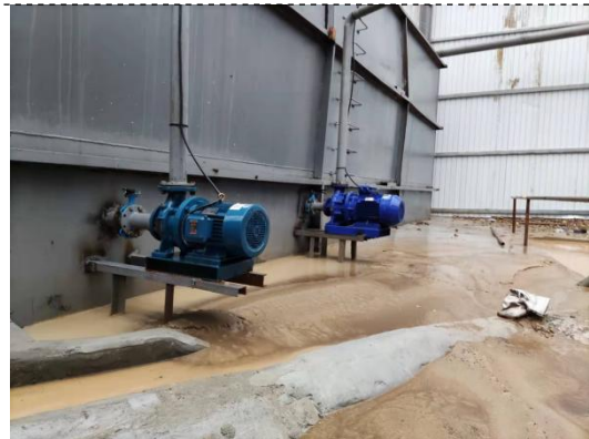
水泵类减震基础
