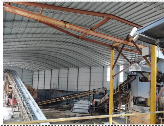
生产线封闭式厂房
