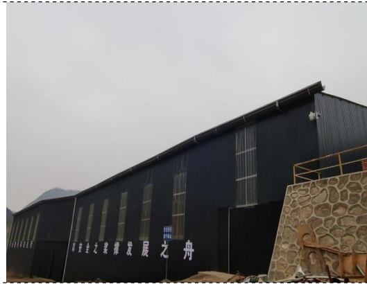
生产线封闭式厂房
