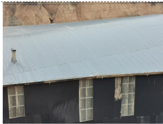
15m 高排气筒
