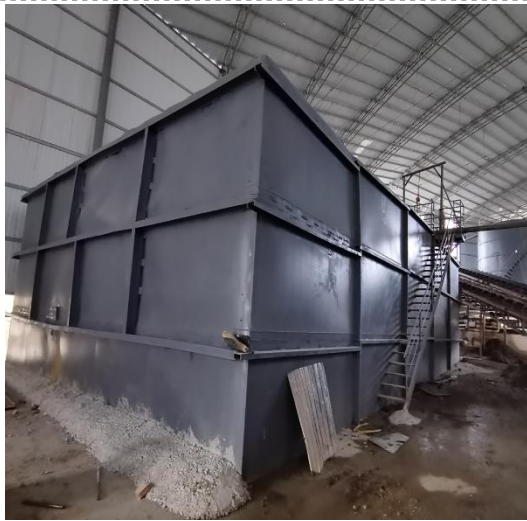
厂区 900m 3 清水池
