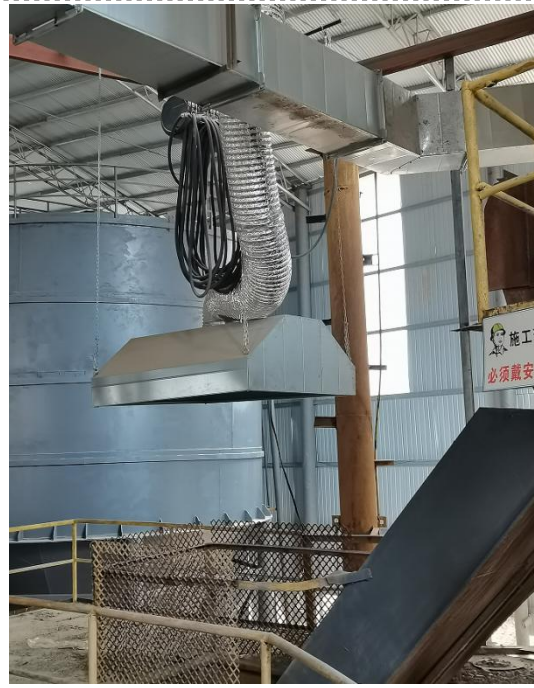
鄂式破碎废气收集系统（集气罩）
