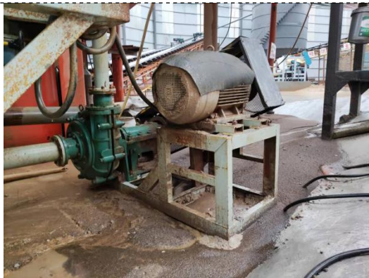
水泵类减震基础
