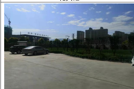
施工营地恢复
