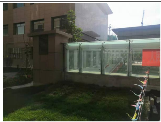
地下车库排风口
