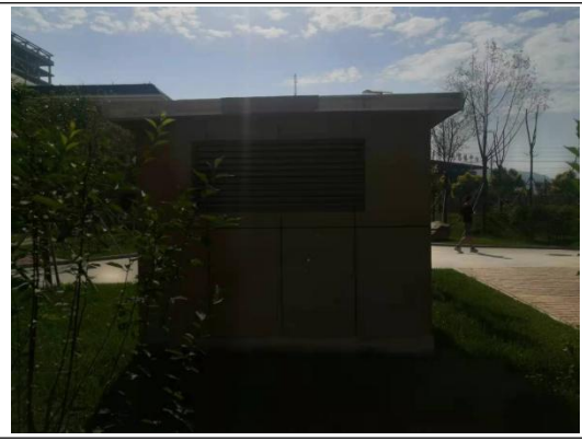
地下车库排风口
