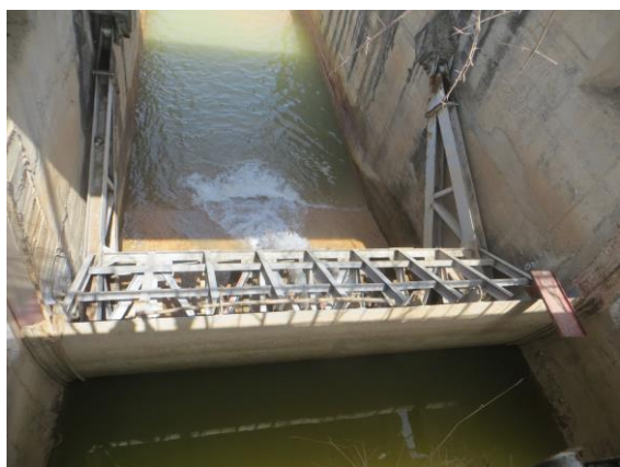
生态下泄流量无障碍工程措施
