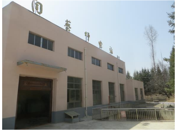
水电站发电厂房外景
