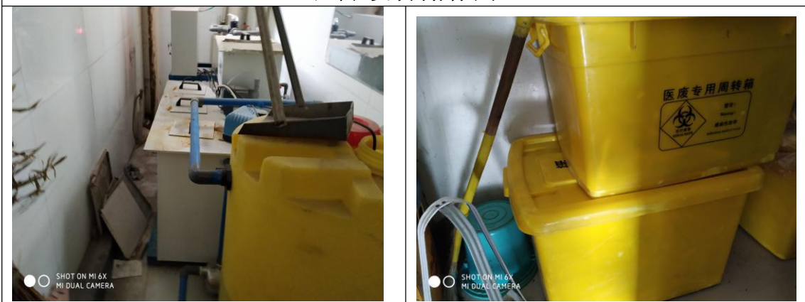
医疗废物暂存间
